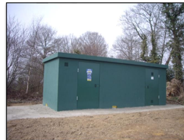
Figure 3 : Exemple de poste de livraison
