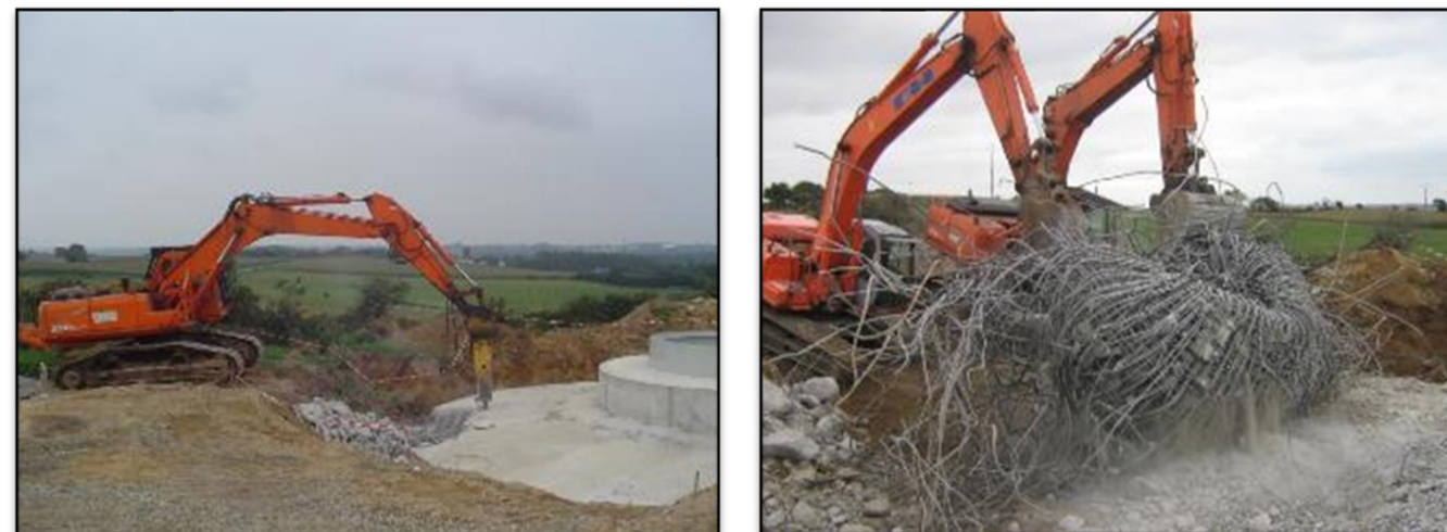
Figure 16 : Eclatement des fondations (à gauche) et enlèvement du ferrailage (à droite)
