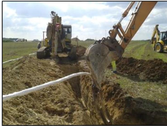
Figure 10 : Enfouissement des réseaux
