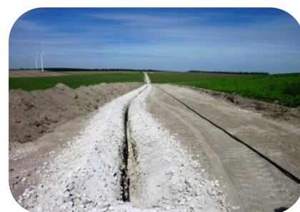
Réalisation des pistes et du câblage
