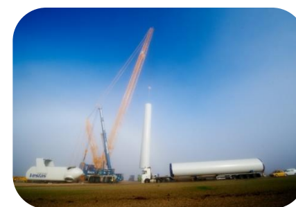
Livraison et Montage des tronçons de mâts
