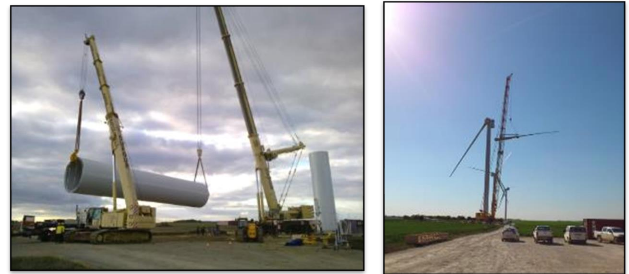
Figure 11 : Montage des éléments du mat (à gauche) et de l'hélice « pale par pale » (à droite)
