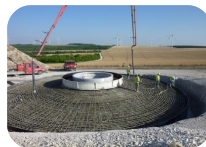
Coulage de la fondation
